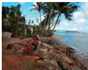
被災して破壊された護岸 (フィジー・ラミタウン)
