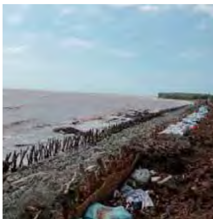
伝統技術であるメレルーカを用いた海岸防護 (ベトナム・ピンチャウ)
