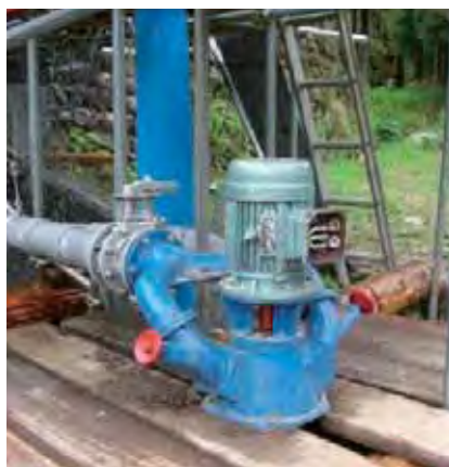
高落差型(ターゴインパルス)の発電設備
