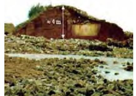
写真1:崩壊した第2代海岸堤防の断面
