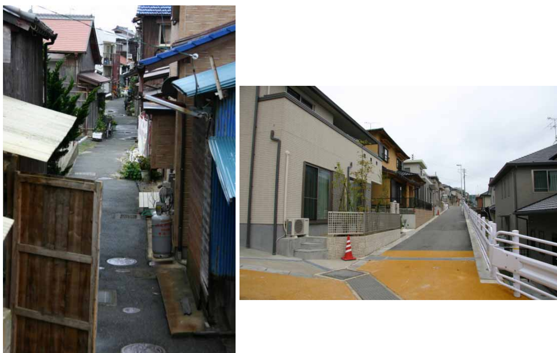
図 3.1-(1) 西浦地区の込み入った細い路地と家々(写真左)、玄界島の新しい集落の道路と家々(いずれも 2008 年 5 月撮影)(写真右)
