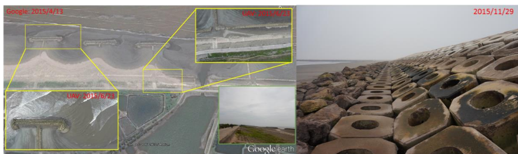
図 3.1-(9). ハイハウ海岸での T 型突堤(左)と建設中の堤防(左)
